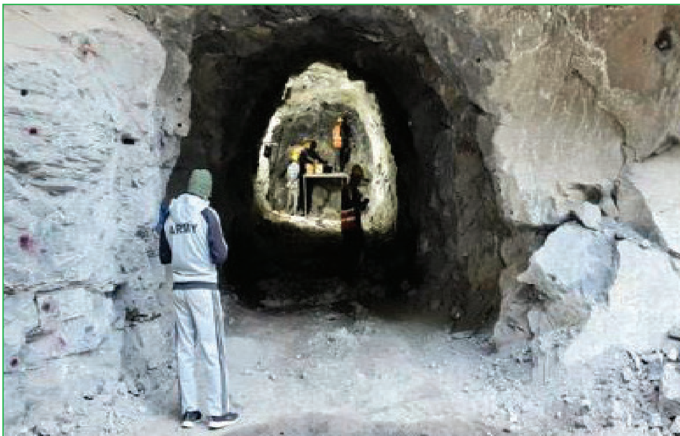
फुकोट कर्णाली अर्ध-जलाशययुक्त जलविद्युत आयोजनाको पावरहाउसको टेष्ट अडिट निर्माण कार्य
