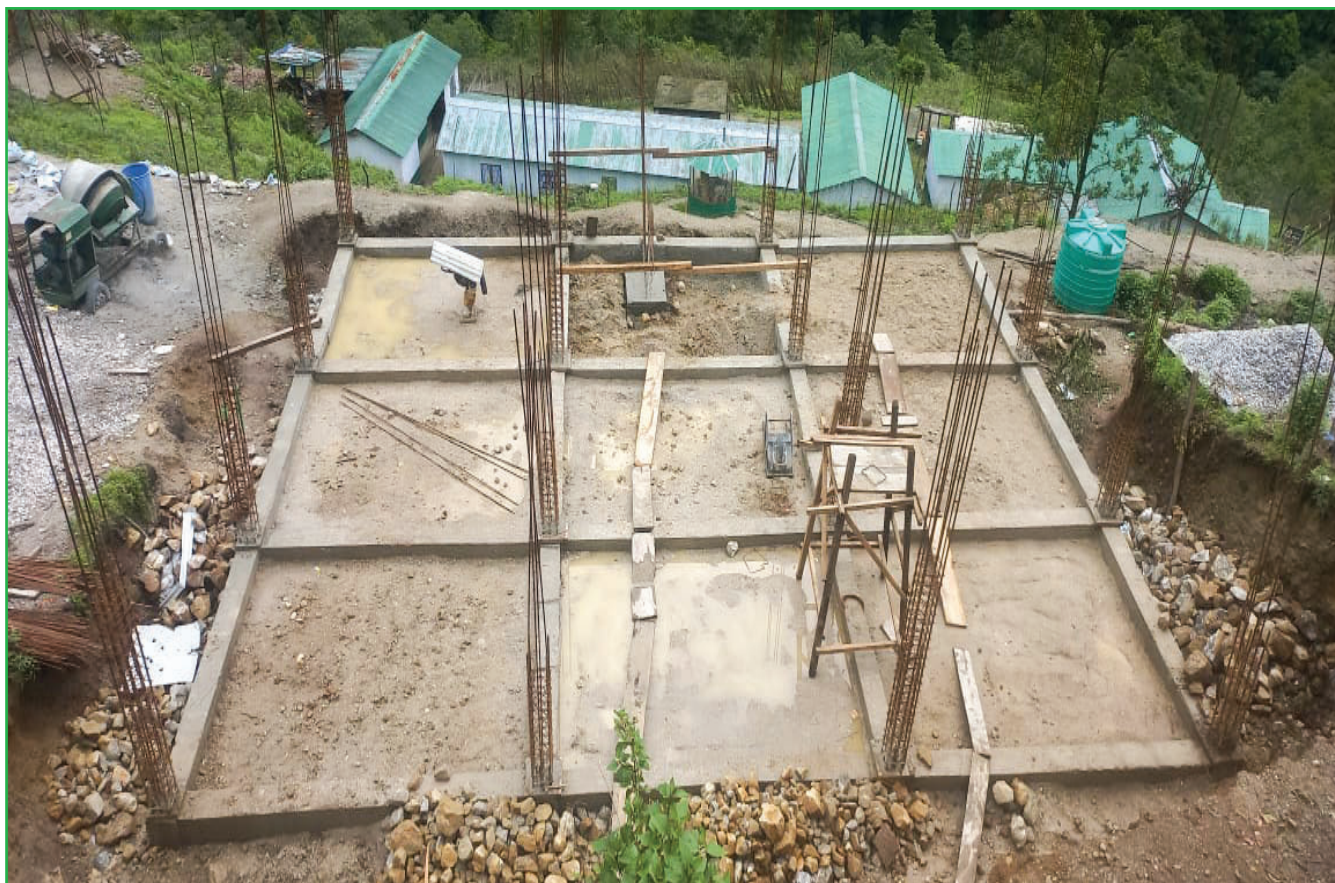
किमाथांका अरुण जलविद्युत आयोजनाको पावर हाउस स्थलमा निर्माण हुदै गरेको कार्यालय तथा आवासगृह
