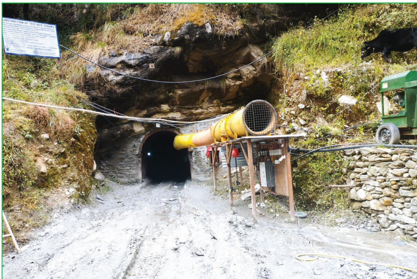
किमाथांका अरुण जलविद्युत आयोजनाको पावर हाउसको टेष्ट अडिट निर्माण कार्य
